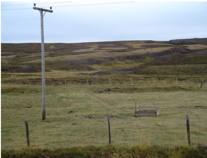
VEGURINN, HORFT TIL ANA
